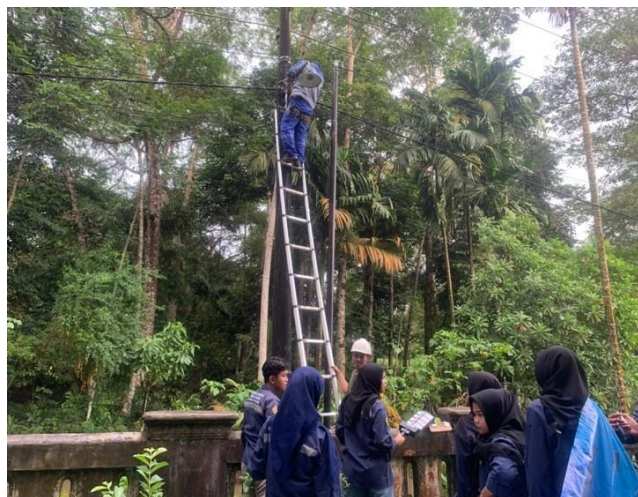
Gambar 6. Pemasangan Lampu PJU Solar Cell
